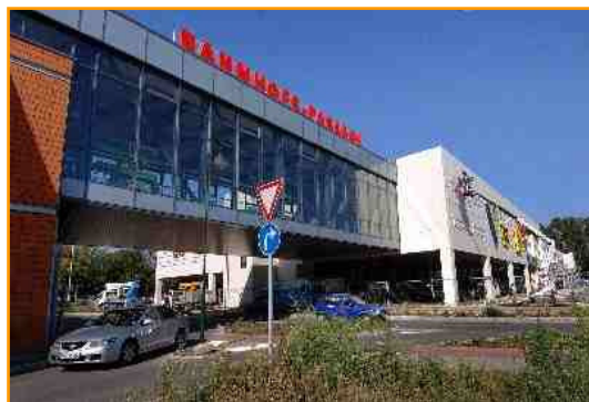
Neubau Bahnhofspassage Bernau
